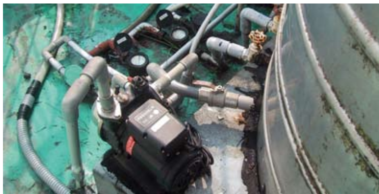
頂樓加蓋有水塔有管線，即有清洗、修繕之需，若承租於此，要注意門戶安全
