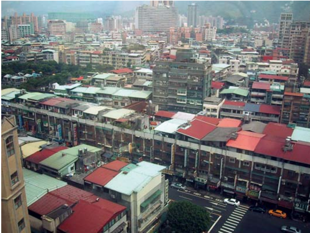
頂樓加蓋大多為鐵皮屋頂
